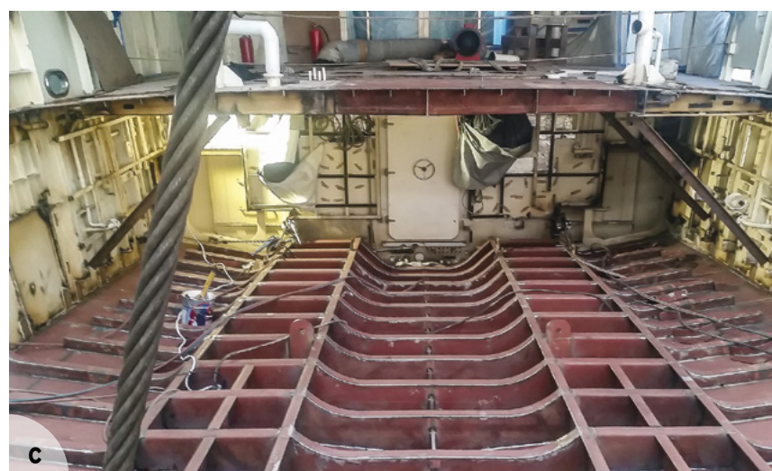
Operazioni di allungamento su Lady Jade: la foto a) mostra lo scafo tagliato privo di parte del fondo. Nella foto b) si vede lo scafo tagliato con il nuovo fondo ed i nuovi braccetti portaelica necessari per le linee d'assi più lunghe. La foto c) mostra le strutture del nuovo fondo.
